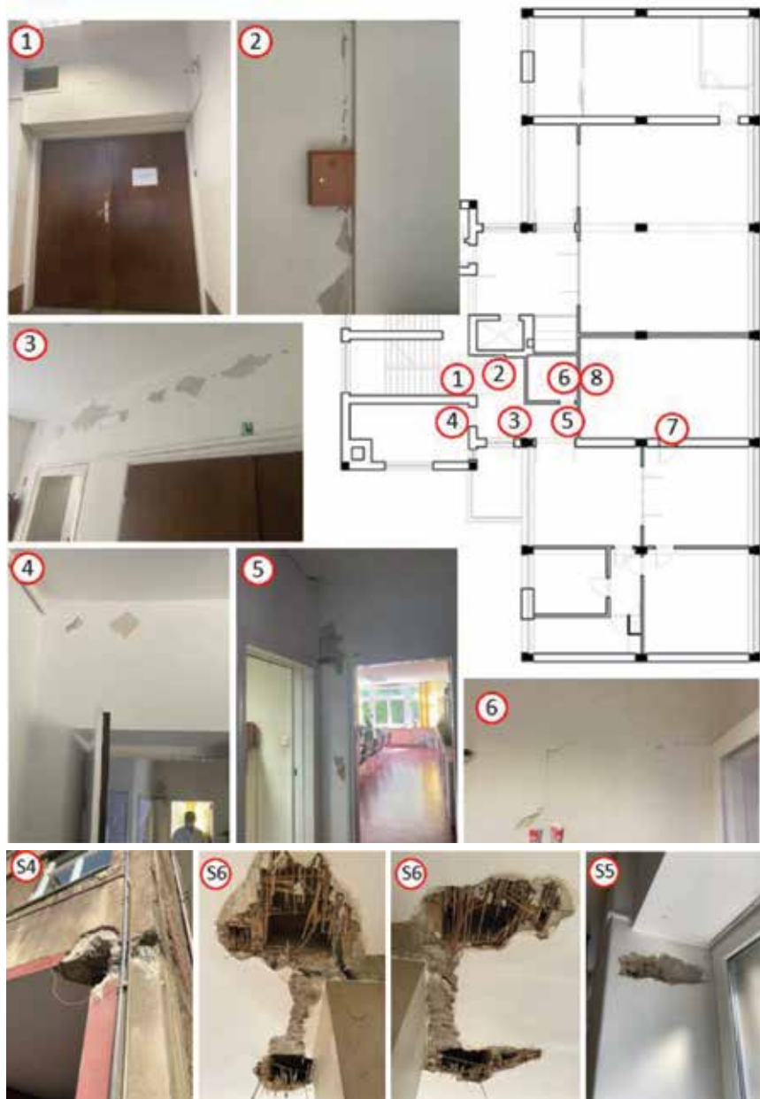
Prikaz položaja oštećenja u zgradama Fakulteta političkih znanosti
