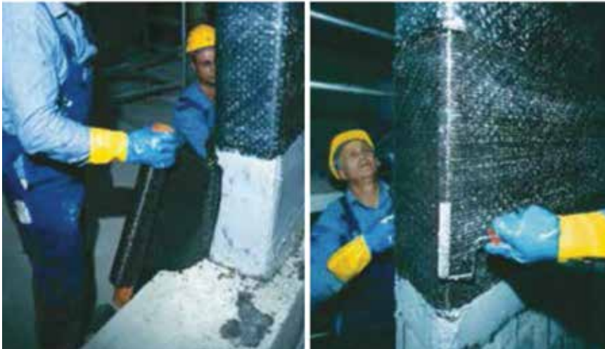
Izvedba obavijanja stupova CFRP tkaninom u punoj visini, a greda u zoni čvorova
