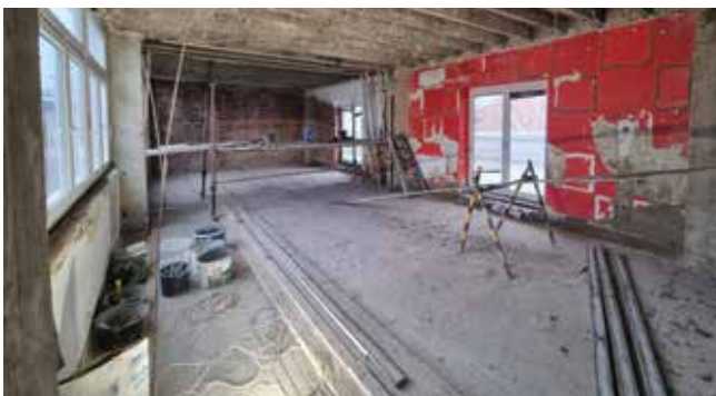
Detalji izvedbe novih stropova
