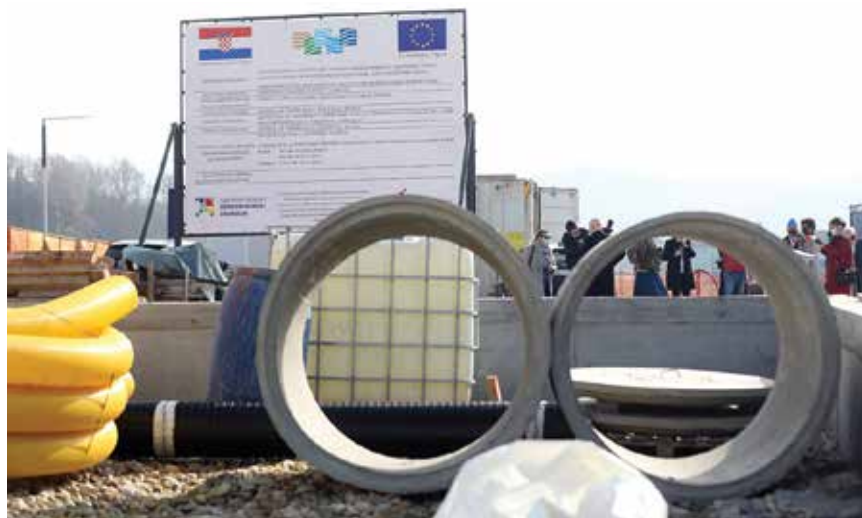
Detalj s gradilišta (Foto: Ivan Agnezović)
