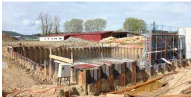
Izgradnja uređaja za pročišćavanja otpadnih voda (Foto: Varkom)
