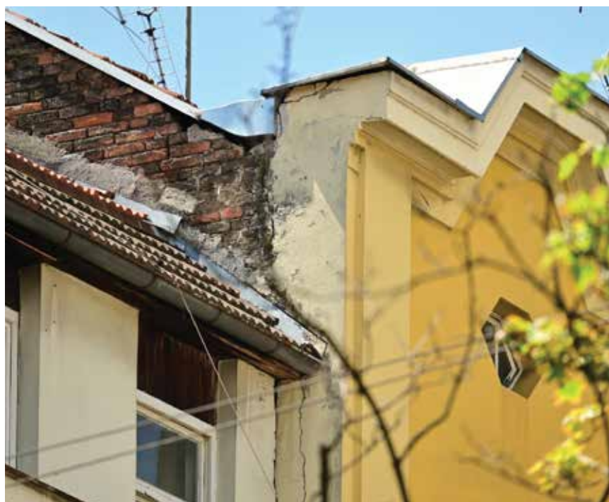
Pogled na istočni zabatni zid
