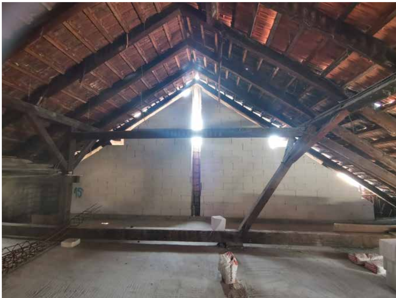
Saniranje zabatnog zida u potkrovlju zgrade
