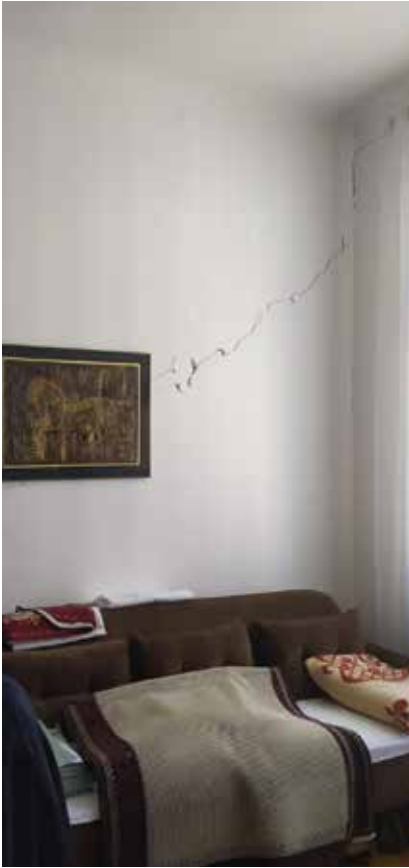
Oštećenja uslijed potresa
