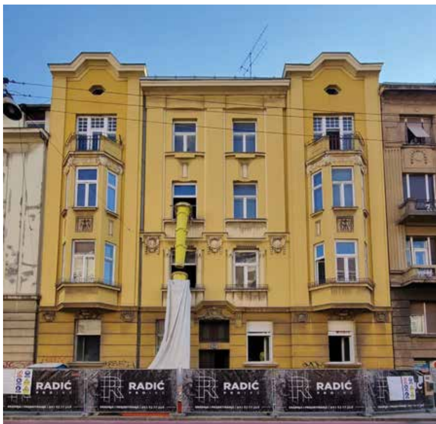
Pogled na ulično pročelje stambene zgrade, Boškovićevo 28, Zagreb
