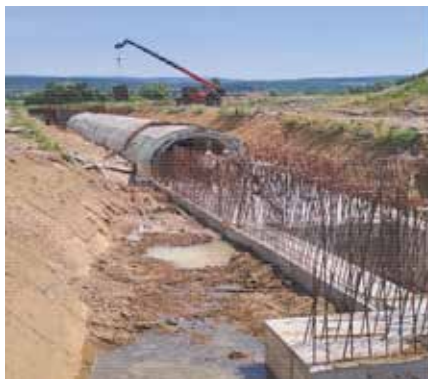
Temeljni ispust izlazne građevine sa slapištem
