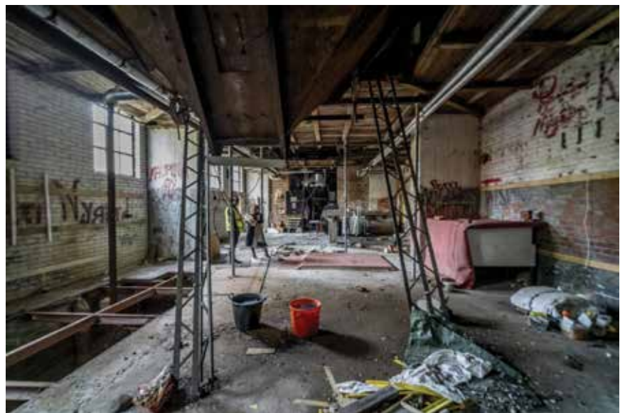
Zatečeno stanje u unutarnjem dijelu silosa (foto: Kari Pullinen)
