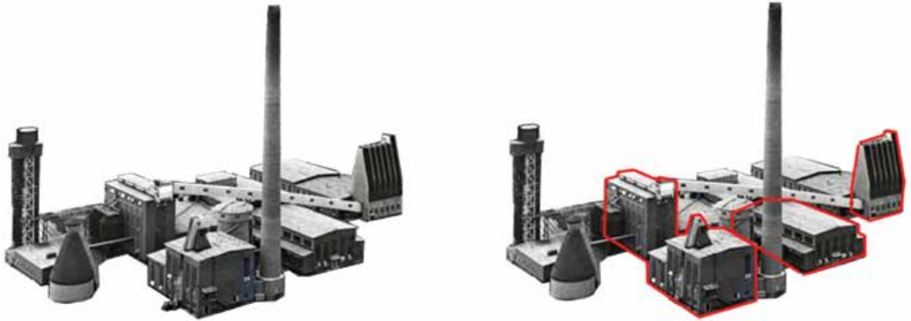
Preostale zgrade koje su sačuvane nakon zatvaranja tvornice (označene crvenom bojom)
