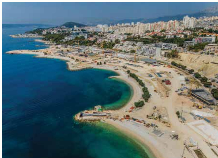
Građevinski radovi napreduju prema planu
