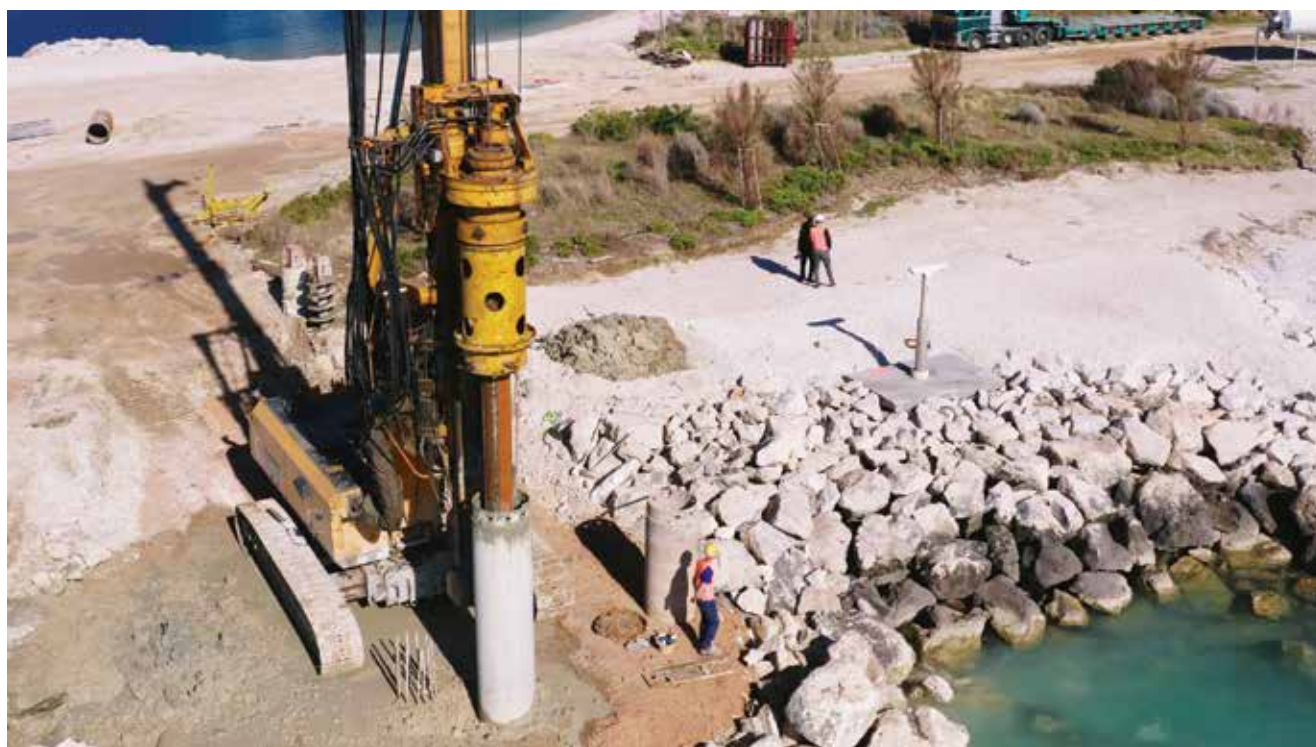
Detalj s gradilišta
