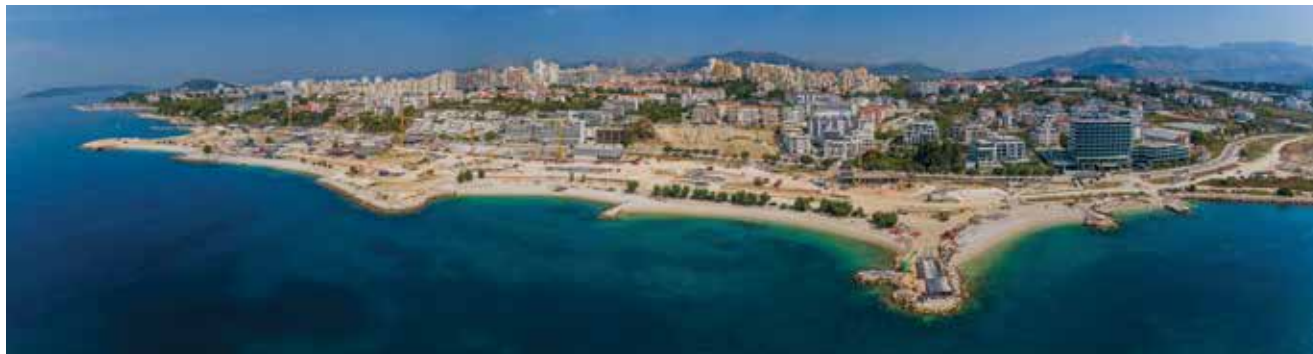
Gradilište snimljeno iz zraka (foto: Zvonimir Barišin / PIXELL)
