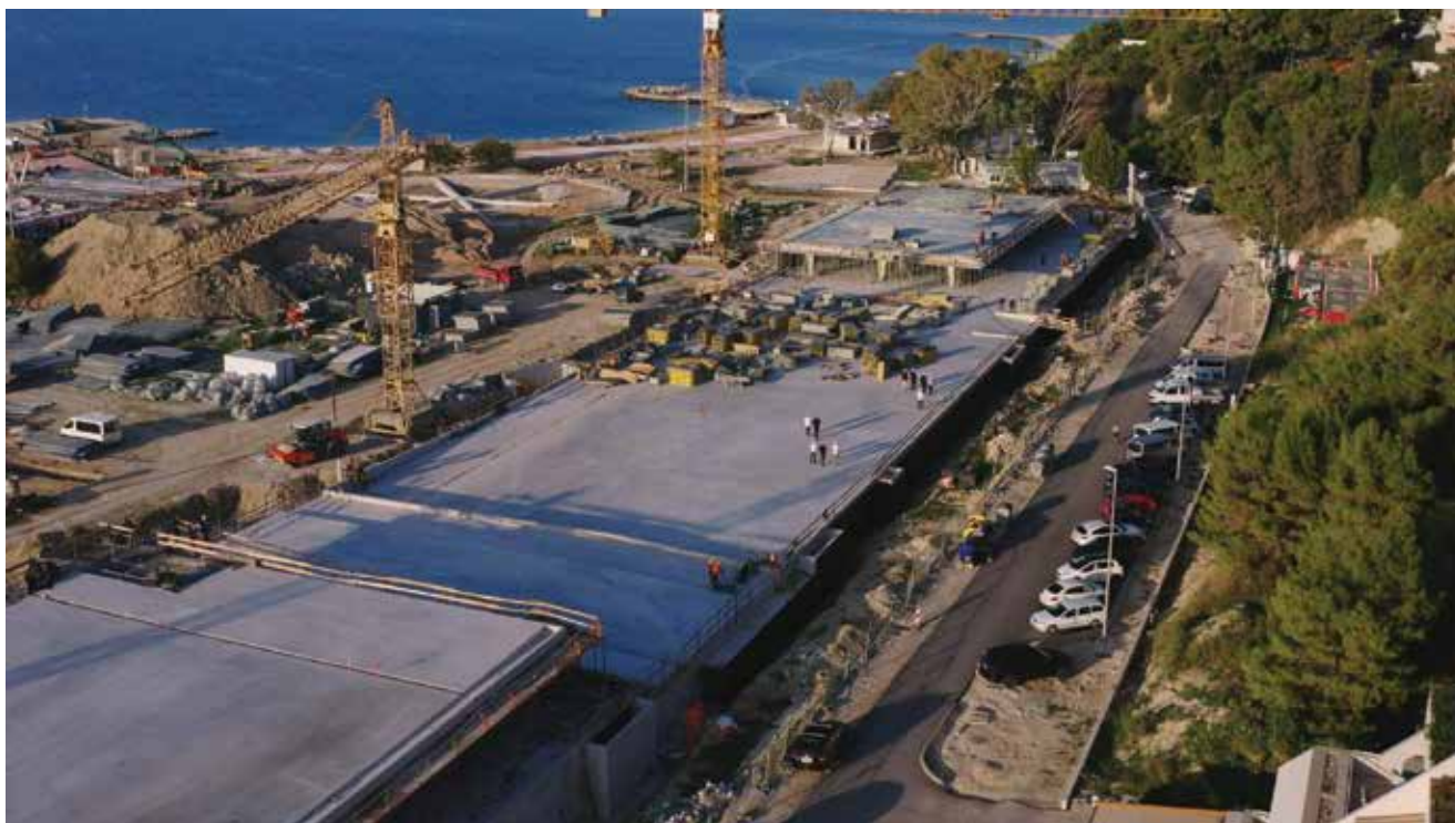
Gradilište snimljeno u listopadu 2024.
