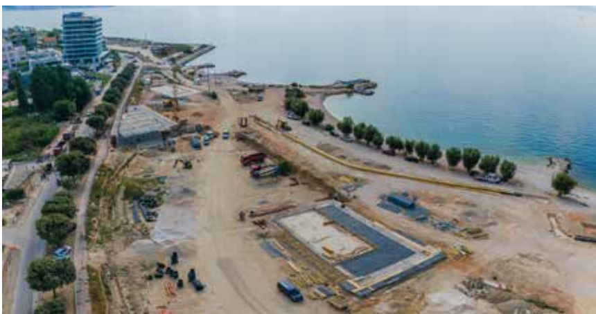
Detalji s gradilišta (foto: Zvonimir Barišin / PIXELL)
