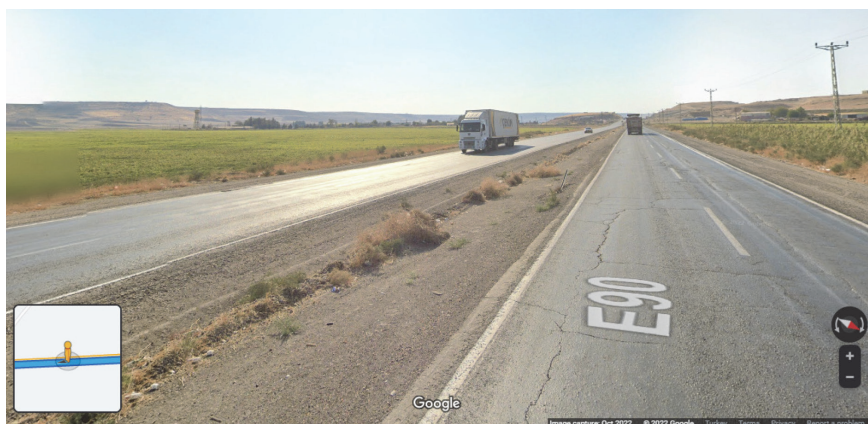
Slika 4. Kolnički trak autoceste Cizre – Silopi i prikaz kolnika (Google Earth) [60]
