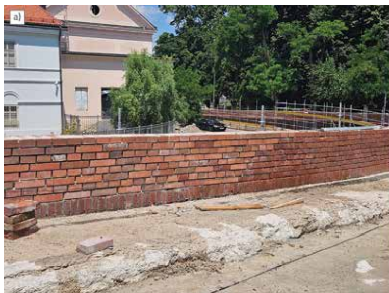
Slika 13. a) Sanacija opečnog zida ograde, b) Prikaz pojačanja ograde
