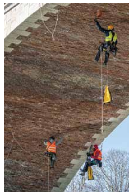
Slika 18. Postavljanje mjerne opreme na intrados luka
