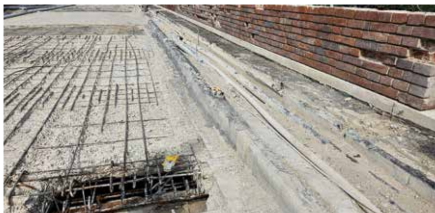
Slika 16. Dio betona gornje strane kolničke ploče uklonjen je hidrodinamičkim postupkom
