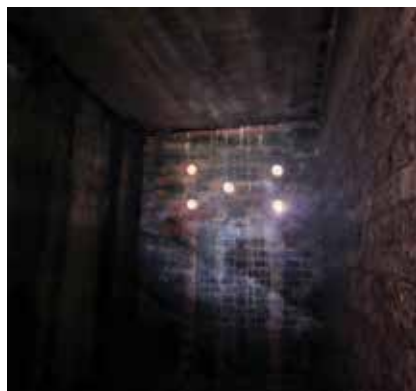
Slika 15. Otvori za prozračivanje izvedeni u vanjskome zidu stupišta
