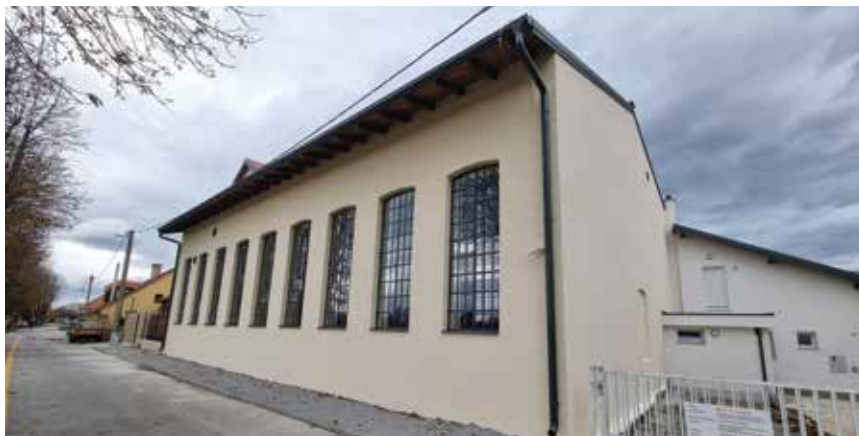
Pogled na obnovljenu fasadu Gradske munjare u Sisku
