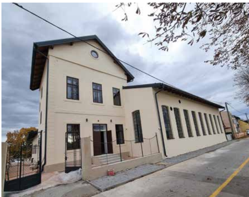
Pogled na gradilište Gradske munjare u Sisku
