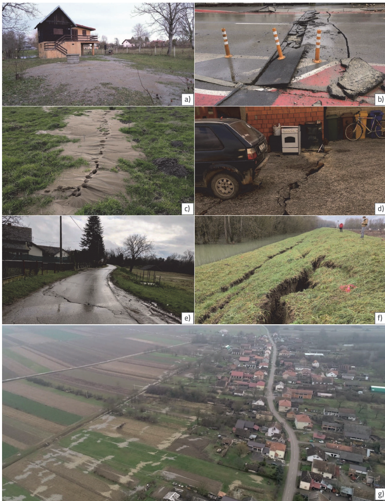
Slika 3. Pojave likvefakcije nastale kao posljedica glavnog potresa 29.12.2020.: a) izbacivanje pijeska kroz bunar u Letovaniću; b) oštećenje kolničke konstrukcije u Ul. Nikole Šipuš u Sisku i izbacivanje instalacija prema površini; c) stošci pijeska kraj Bresta Pokupskog; d) pukotine razmicanja tla u naselju Brest Pokupski; e) pukotina na cesti u Boku Palanječkom koja ulazi u naselje; f) pukotina nastala kao posljedica razmicanja na nasipu uz Savu u Galdovu, Sisak; g) zona likvefakcije u naselju Palanjek
