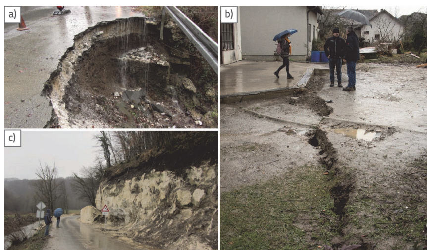
Slika 4. Pojave klizišta nastale kao posljedica glavnog potresa 29.12.2020.: a) plitko klizište na cesti kod naselja Donji Hruševac registrirano 4.1.2021.; b) pukotina nastala bočnim razmicanjem u naselju Bok Palanječki registrirana 3. 1. 2021.; c) odron na cesti prema mjestu Pecki nastao 29.12.2020. registriran 3.1.2021.
