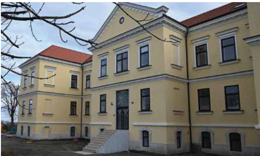
Obnovljena zgrada Stare interne u Općoj bolnici "dr. Ivo Pedišić" u Sisku
