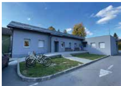
Obnovljeni Dom zdravlja SMŽ u Glini
