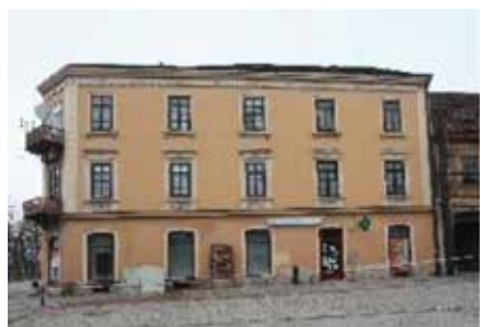
Sisak - Rimska 1, Zgrada Liebermann
