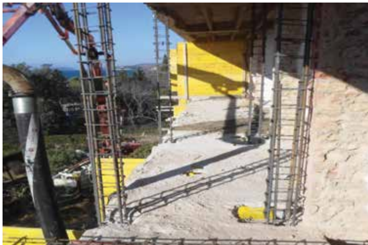
Ojačanje zidova ubacivanjem novih AB vertikalnih serklaža
