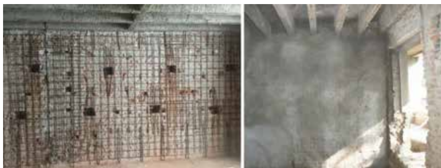
Primjer torkretiranja
