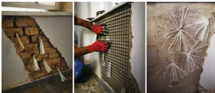
Primjer izvođenja FRCM sustava s FRP užadi
