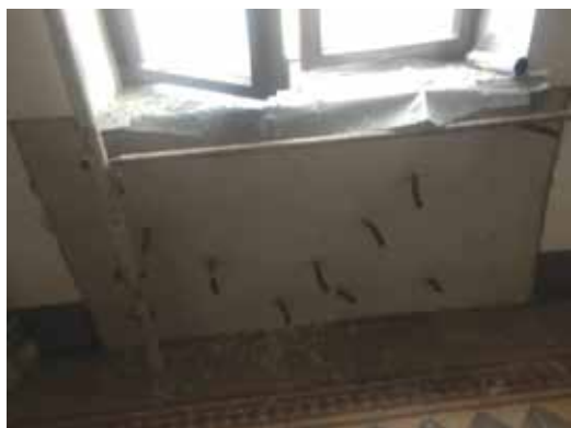
Injektiranje parapeta
