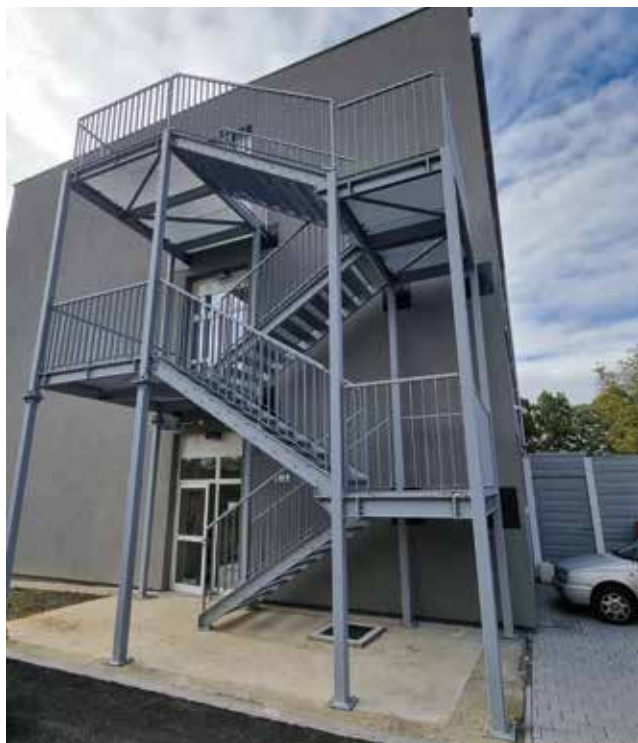
Novo protupožarno stubište
