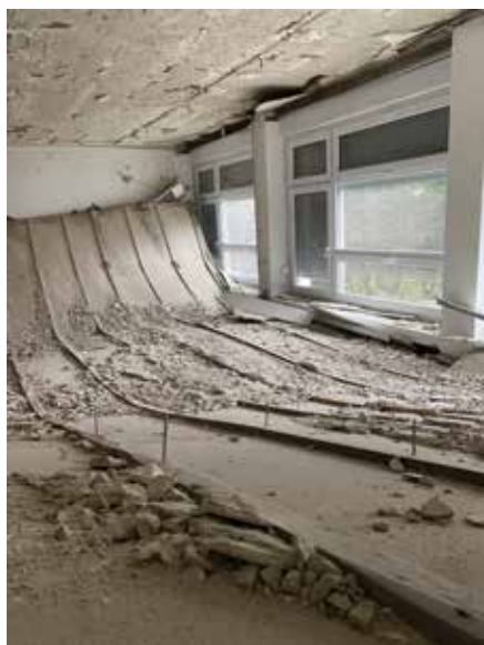
Oštećenja od potresa na zgradi fakulteta
