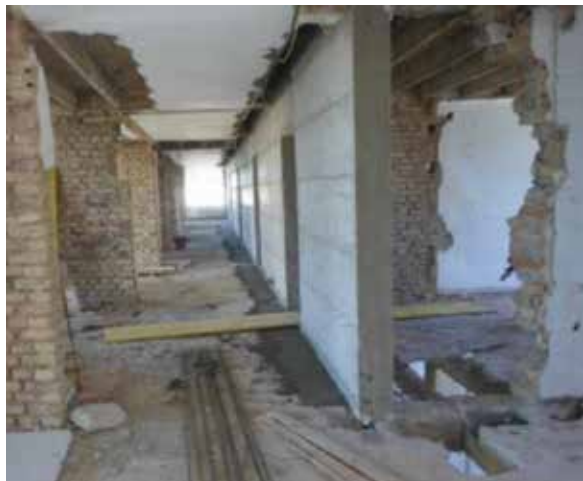
Izvedba zamjenskog AB zida
