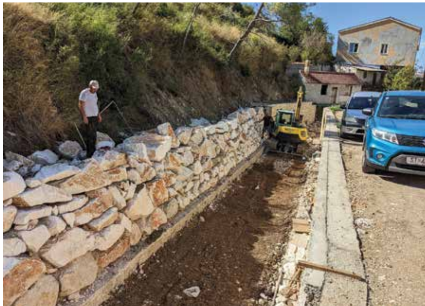
Izvedba kamene obaloutvrde
