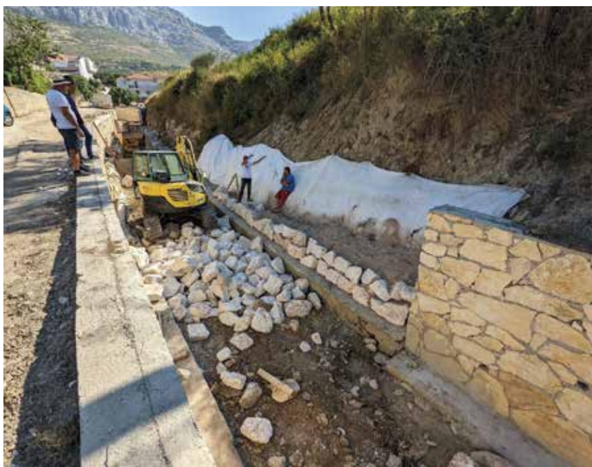
Postavljanje geotekstila za stabilizaciju slojeva tla
