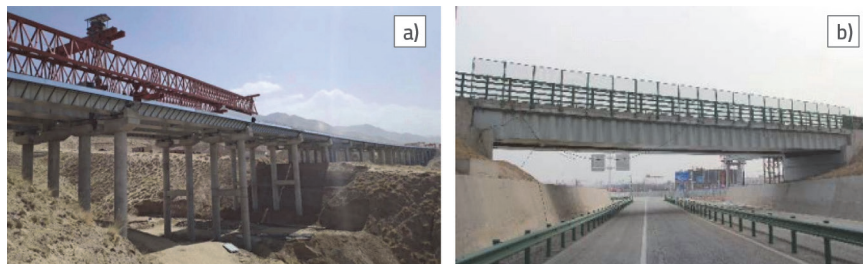
Slika 1. Izvedba i uporabno stanje mostova sa spregnutim sandučastim nosačima u Kini: a) Most na autocesti Dunhuang do planine Dangjina; b) Most sa slobodno oslonjenim nosačima u zračnoj luci Jingzhong
