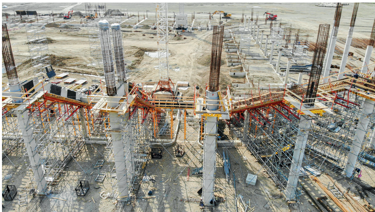
Gradilište nogometnog stadiona Opus Arena u Osijeku, PERI UP modularni sustav skele kao iznimno učinkovito rješenje za složene geometrije tribine
