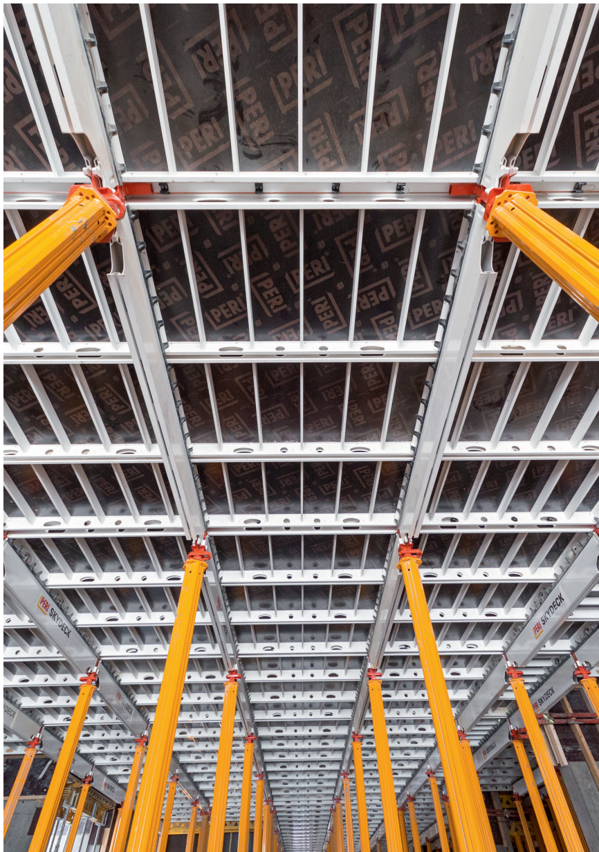
SKYDECK sustav stropne oplate: jednostavna primjena i visoka kvaliteta otiska betonske površine
