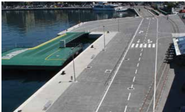
Primjeri ugrađenih betonskih opločnika na trajektnome pristaništu
