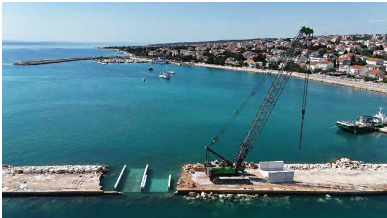
Pogled na gradilište južnog lukobrana u luci Novalja (foto: Županijska lučka uprava Novalja)
