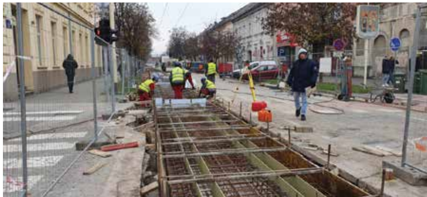
Projekt modernizacije tramvajske infrastrukture jedna je od najvećih investicija u Osijeku
