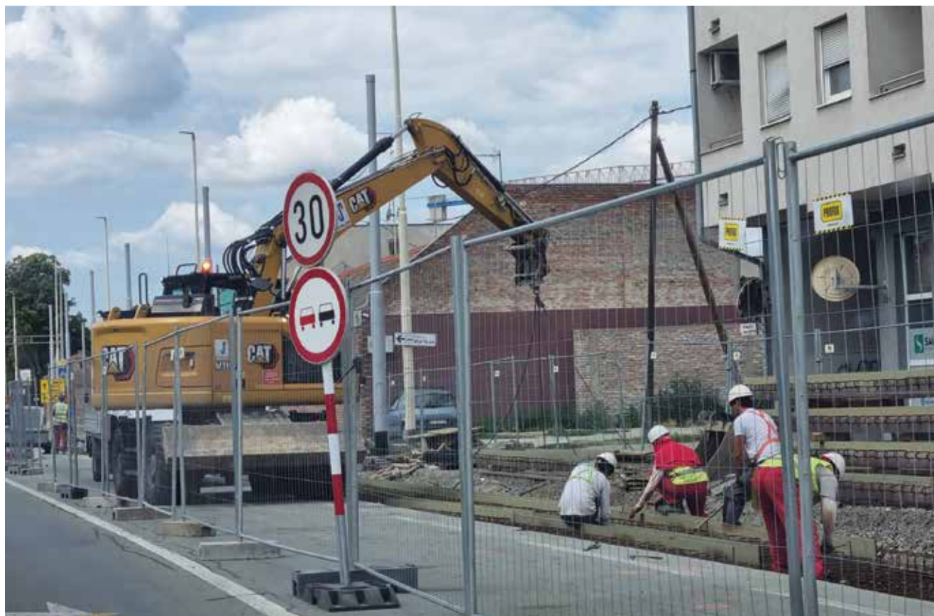
Radovi na gradilištu tramvajske mreže
