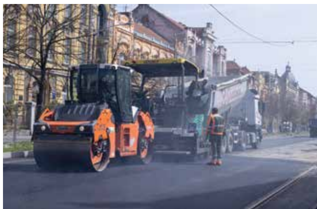
Radovi na gradilištu tramvajske mreže
