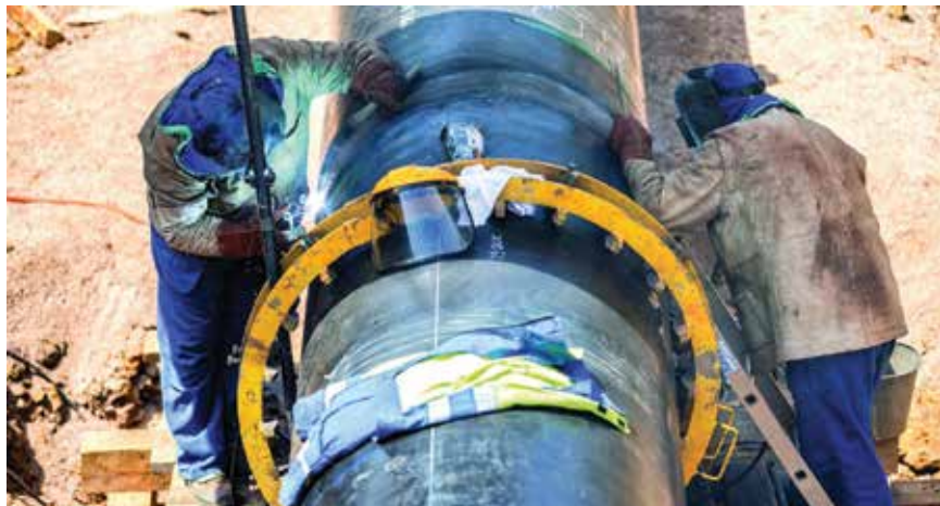
Radovi na zavarivanju cijevi za plinovod
