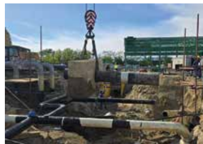
Radovi na prespajanju cjevovoda (foto: Possum)
