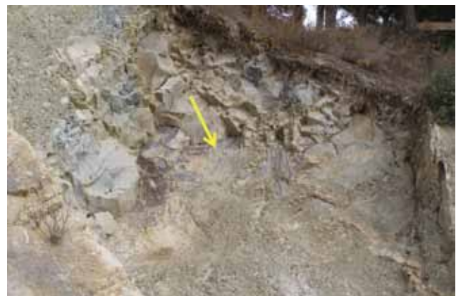
Slika 13. Klizanje po sekundarnim pukotinama
