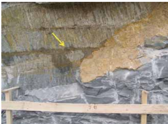
Slika 9. Primjer procjeđivanja vode kroz pukotine u flišu
