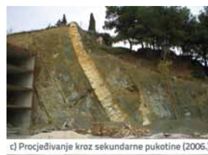
Slika 10. Primjer procjeđivanja kroz sekundarne pukotine
