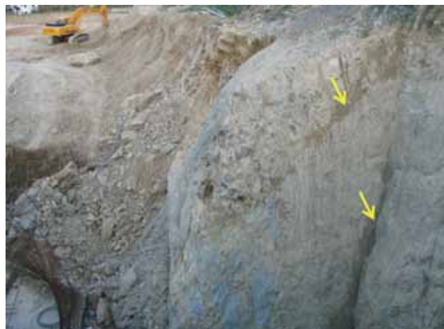
Slika 10. Primjer procjeđivanja kroz sekundarne pukotine
