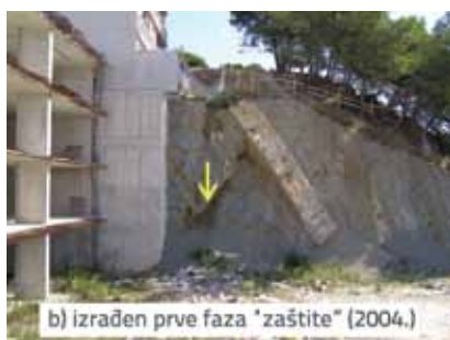
Slika 10. Primjer procjeđivanja kroz sekundarne pukotine
