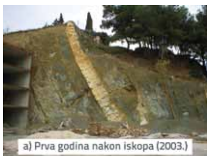
Slika 9. Primjer procjeđivanja vode kroz pukotine u flišu
