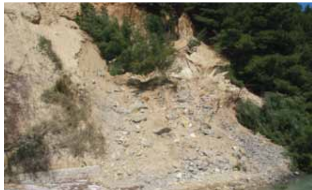
Slika 3. Klizište uz obalu mora na prirodnom klifu u flišnoj naslazi (Split, lokacija Duilovo)
