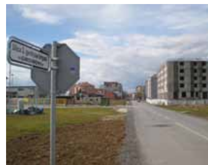
Nove zgrade u Dugom Selu
