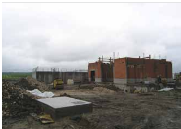
Gradnja uređaja za pročišćavanje otpadnih voda u Otoku
