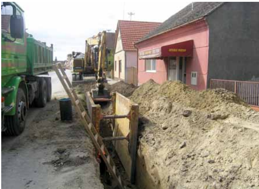
Polaganje kanalizacijskih cjevovoda u Dardi
