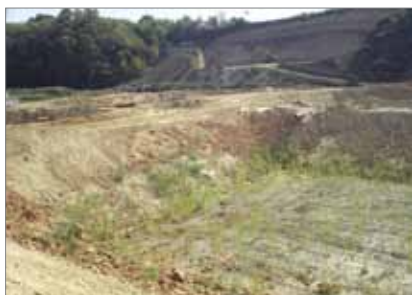
Radovi na lagunama
