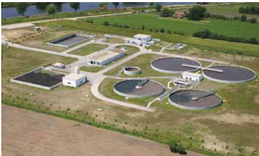
Pogled iz zraka na Jošine – vinkovački uređaj za pročišćavanje otpadnih voda
