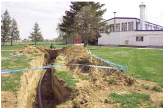
Polaganje vodoopskrbnih cjevovoda u Donjem Miholjcu
