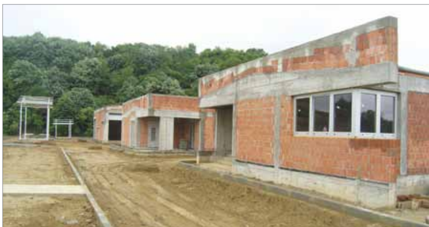
Gradnja popratnih zgrada uređaja za pročišćavanje otpadnih voda
