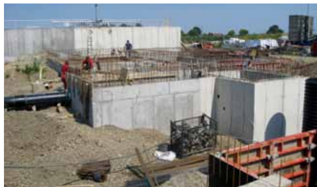
Sadašnje stanje gradilišta uređaja za pročišćavanje u Ivankovu (snimio: T. Puljić)
