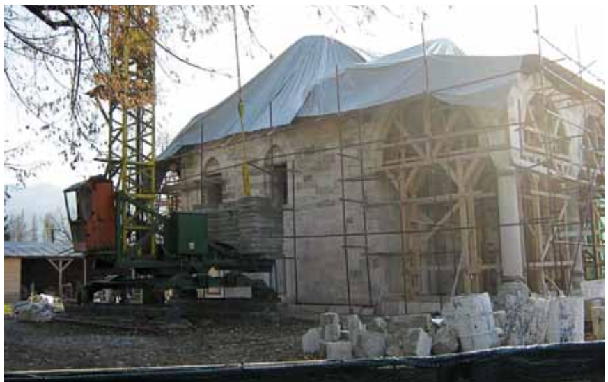
Zidanje kamenih lukova trijema
