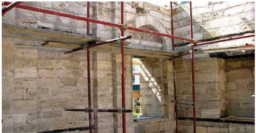
Zidanje kamenih zidova
