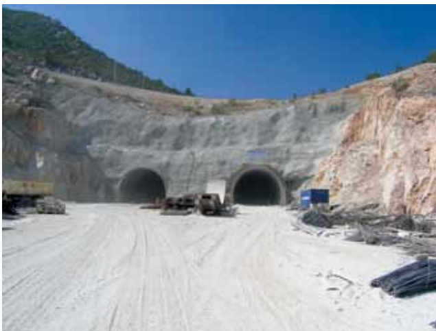
Sjeverni portali tunela Mali Prolog na spojnoj ceste
