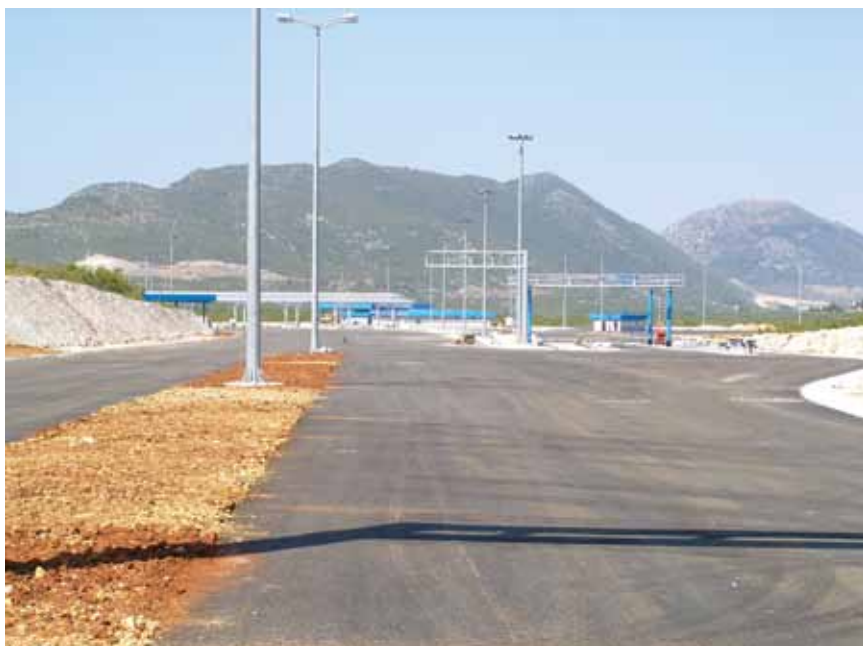
Pogled na dio građevina graničnog prijelaza Metković 2
