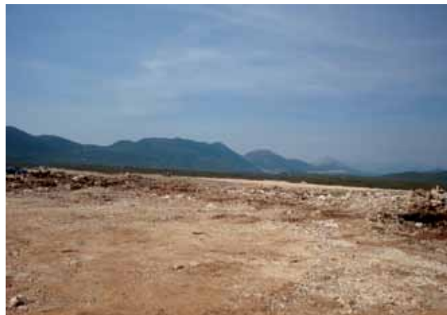
Početak radova na graničnom prijelazu Metković 2
