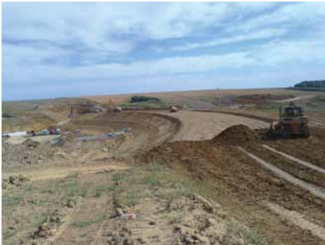
Gradnja zemljane brane Koritnjak
