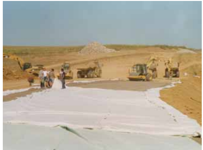
Ugradnja geotekstila u tijelo brane
