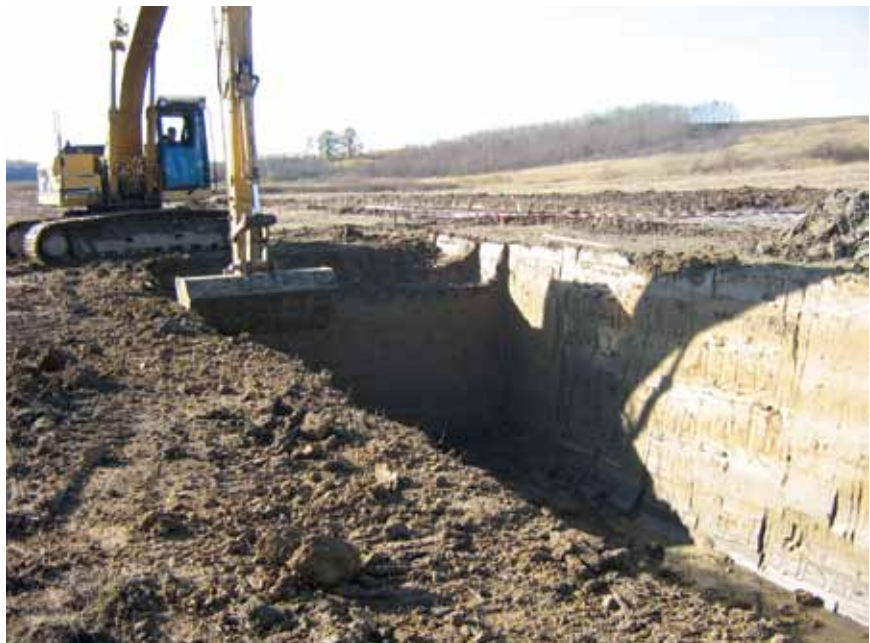
Prvi zemljani radovi u gradnji brane Koritnjak
