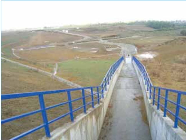
Pogled s brane na bočni preljev
