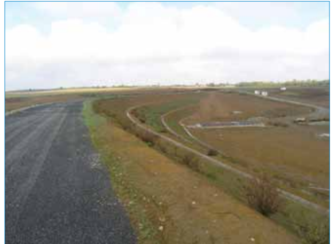
Pogled s desnog boka na praktički izgrađenu branu Koritnjak
