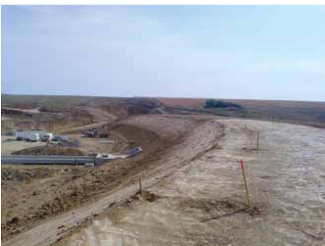
Stanje radova na brani u rujnu 2011.
