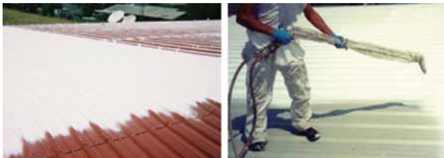
Česti (loš) primjer u praksi, premazivanje krova bijelom bojom
