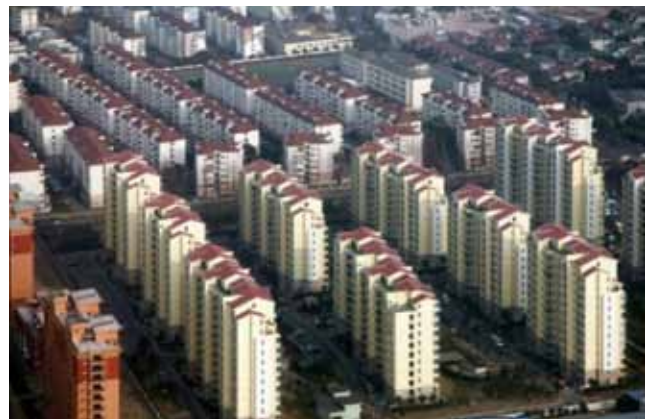
Dio novourbaniziranih dijelova grada Ordosa
