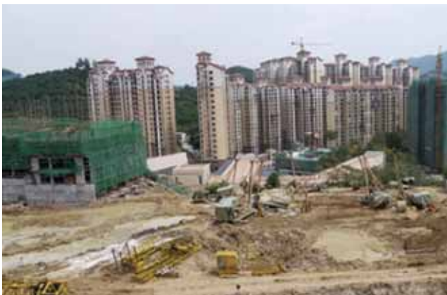
Tipično kinesko gradilište
