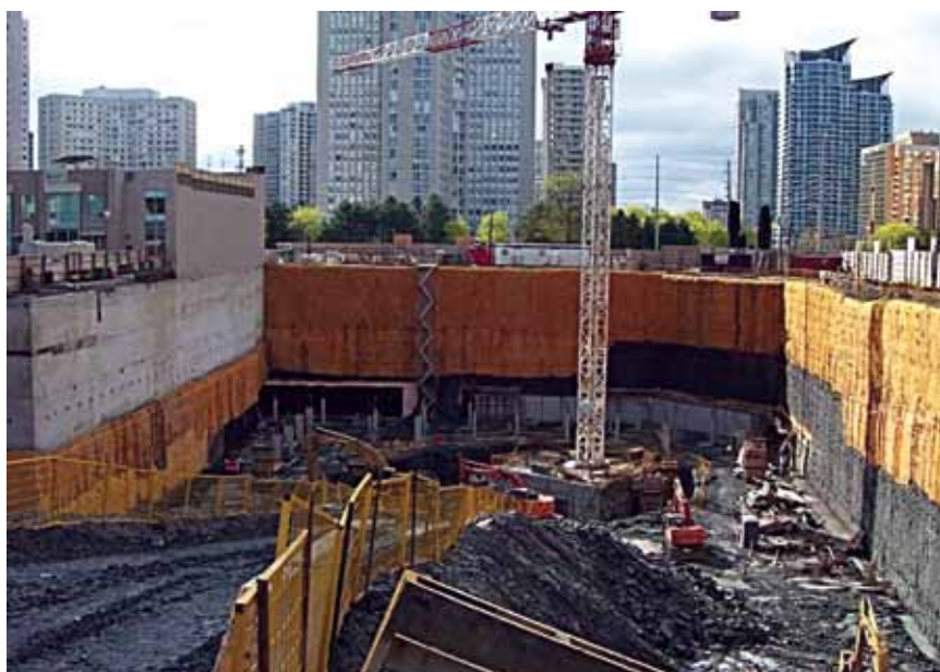
Početak građenja – radovi na iskopu
