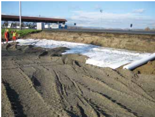
Početak zemljanih radova istočno od sadašnje naplatne postaje
