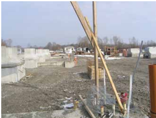
Gradilište novoga cestarinskog prolaza sjeverno od autoceste
