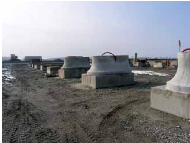
Betonski odbojnici zvani "bikovi" ispred budućih naplatnih kućica
