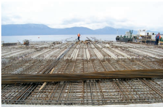
Radovi na gradnji pristaništa
