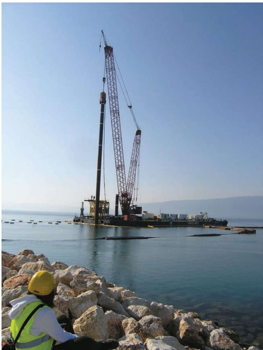
Početak pobijanja jednoga čeličnog pilota u more
