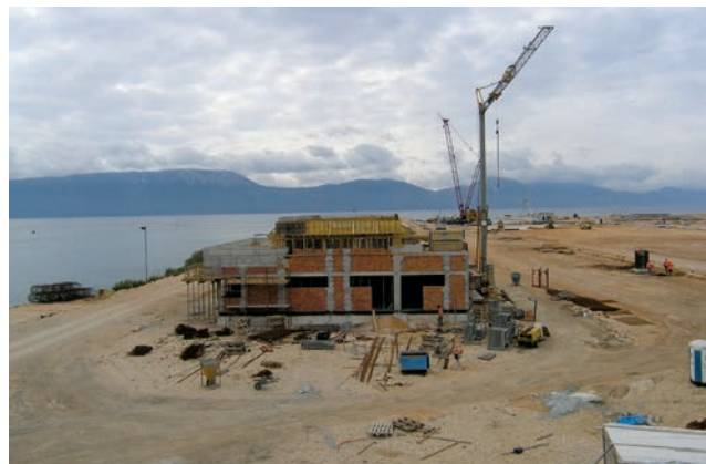
Dio gradilišta s pristaništem i budućom radionicom
