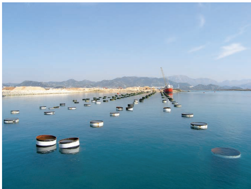
Pogled s teglenice na pobijene pilote
