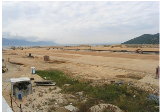
Pogled na gradilište s krova buduće upravne zgrade
