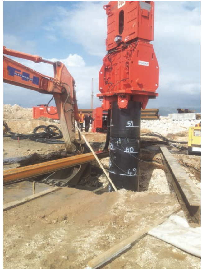
Pobijanje jednog pilota na kopnu pred završetkom
