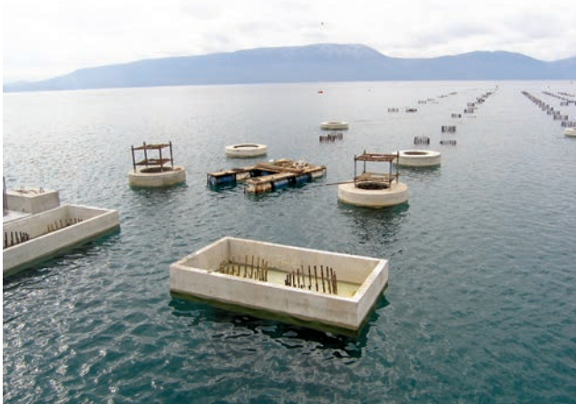
Različite naglavnice za kose i vertikalne pilote
