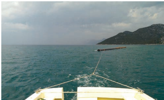
Prebacivanje pilota morskim putem do mjesta ugradnje
