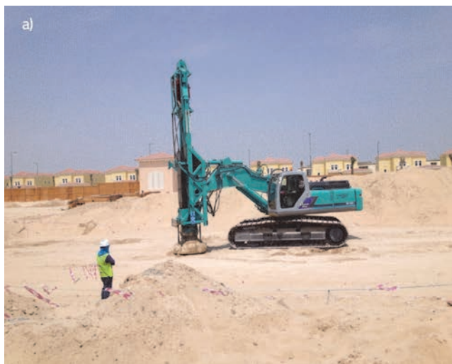
Slika 1. a) stroj za brzo udarno zbijanje; b) stopa za zbijanje s udarnom kapom
