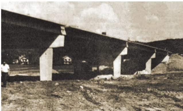
Gradnja mosta preko Novčice u Gospiću
