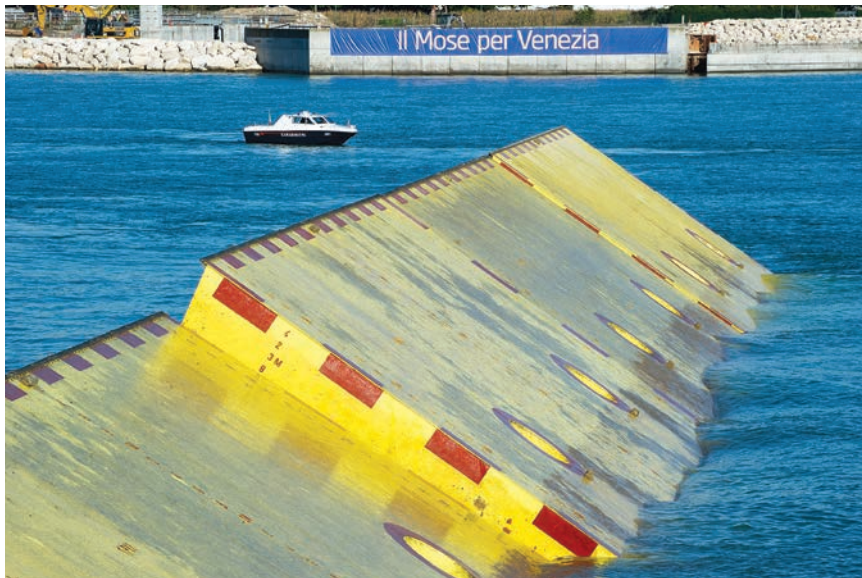
Probno podizanje zaklopnice
