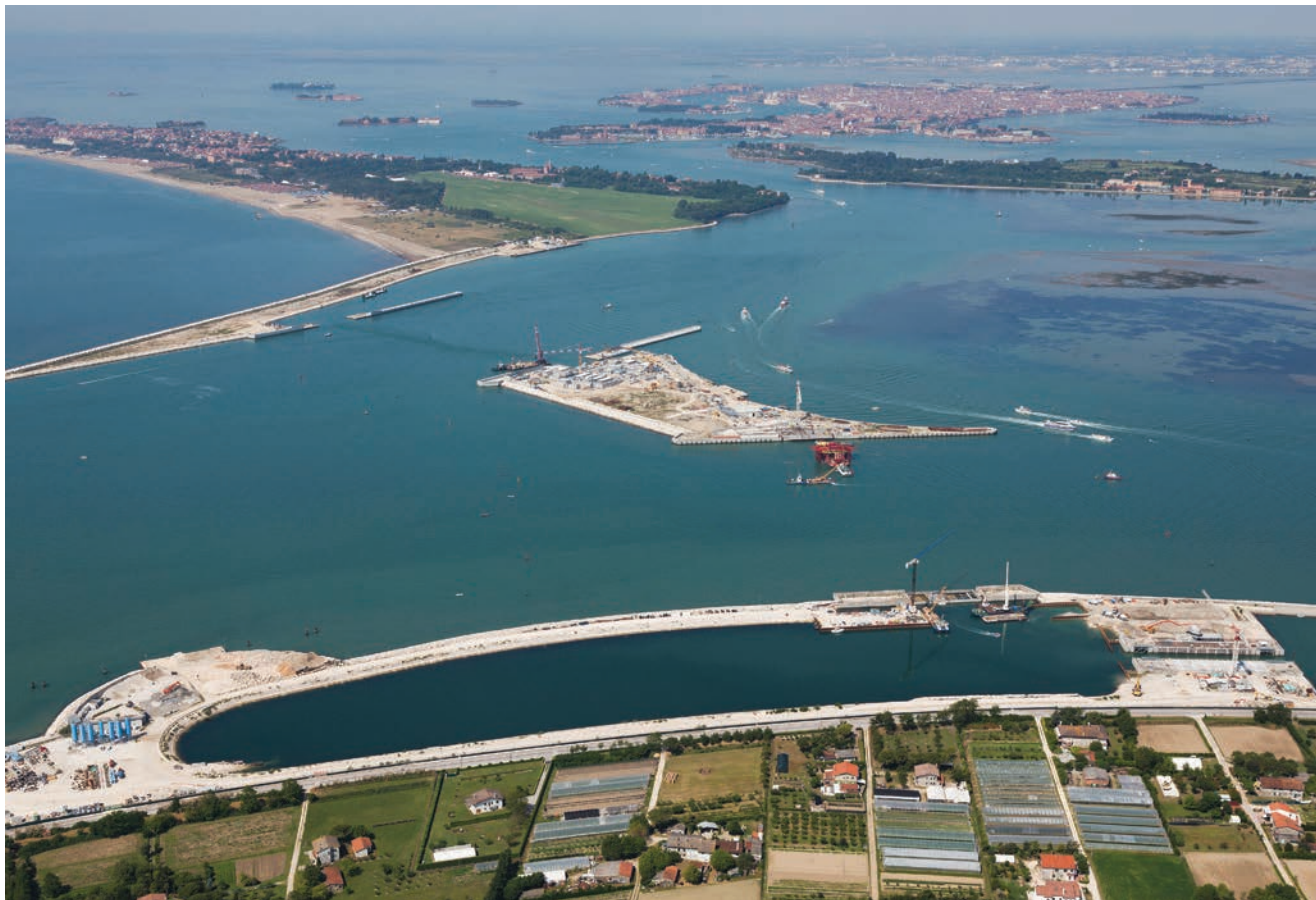
Građevinski radovi na umjetnom otoku u Lido ulazu
