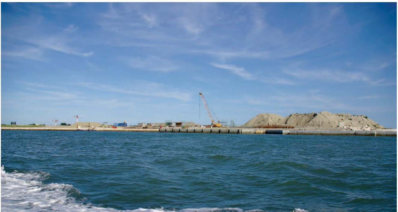
Detalj građevinskih radova
