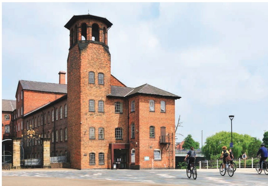
Zgrada bivše tvornice svile u Derbyju koja je prenamijenjena u muzej
