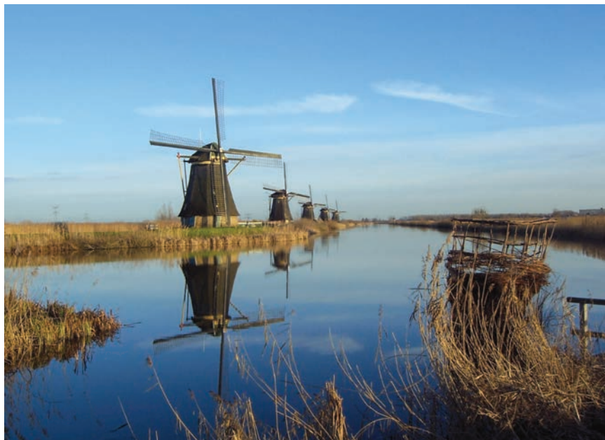
Sustav vjetrenjača Kinderdijk-Elshout u Nizozemskoj
